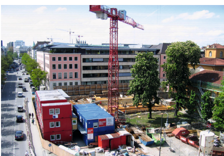
Baubeginn Umbau Lenbachhaus, 5/2010
